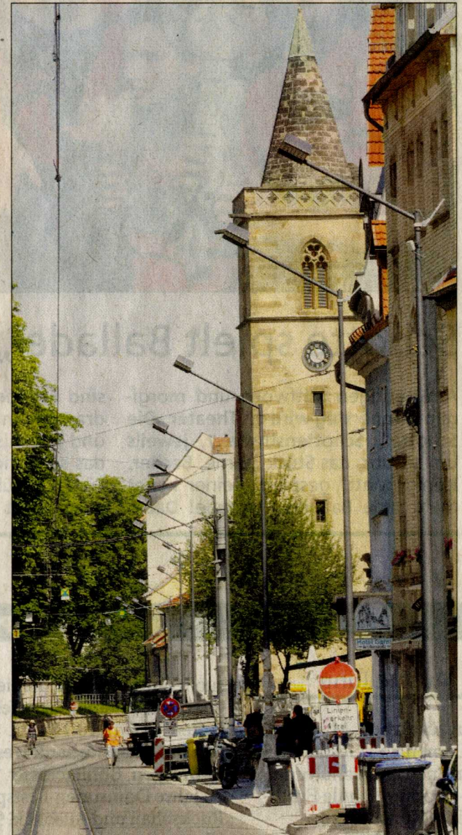
In der Andreasstraße wird noch gebaut. Straßenlampen, Gehwege, Parkbuchten – alles soll bis Ende Juli fertig sein. Foto: Mario Gentzel
